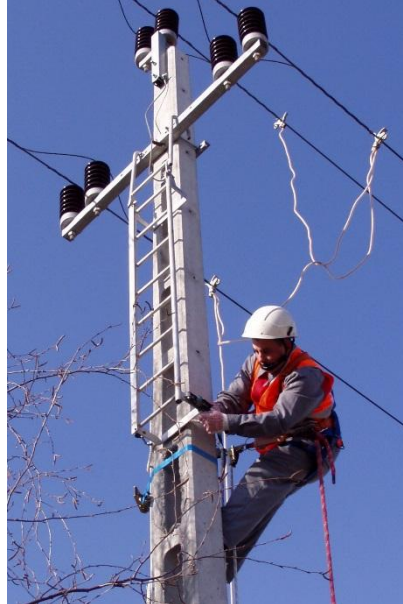
106. Munkaállás felszerelése az áttörésben állva
