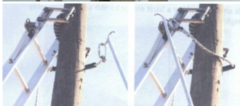
90.-91. Felső rész kötélhurkos rögzítése
