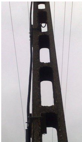
103. Normál áttörésű oszlop (Az áttörés mászható méretű!)
